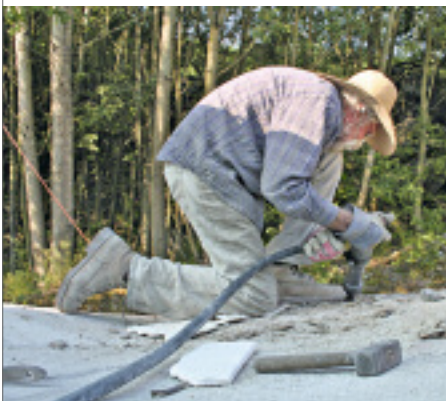
Bild 9: Schwarzenfeld gibt dem Rohblock aus Lausitzer Granit durch Spalten und Materialabtrag die gewünschte Form.
